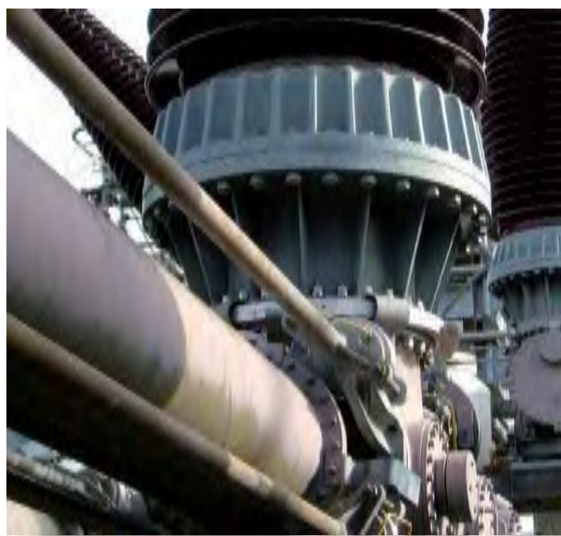
変電所における SF 6 (六フッ化硫黄)で満たされた機器の例
