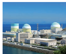
原子力発電所
